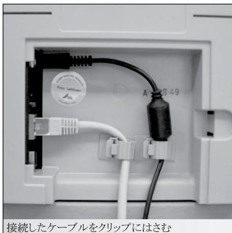
接続したケーブルをクリップにはさむ
